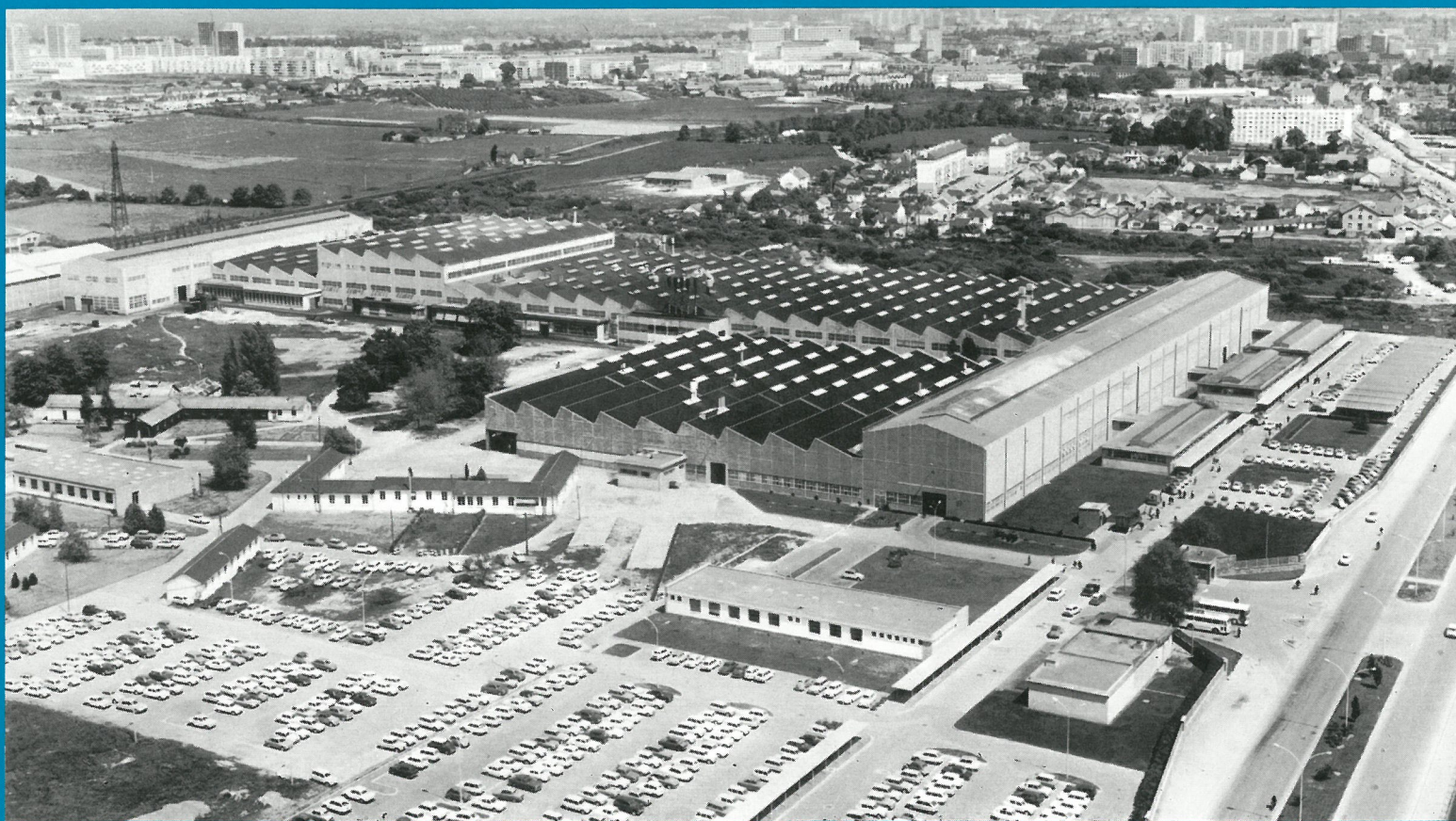
A l'ouest de Rennes, l'usine de la Barre-Thomas.
