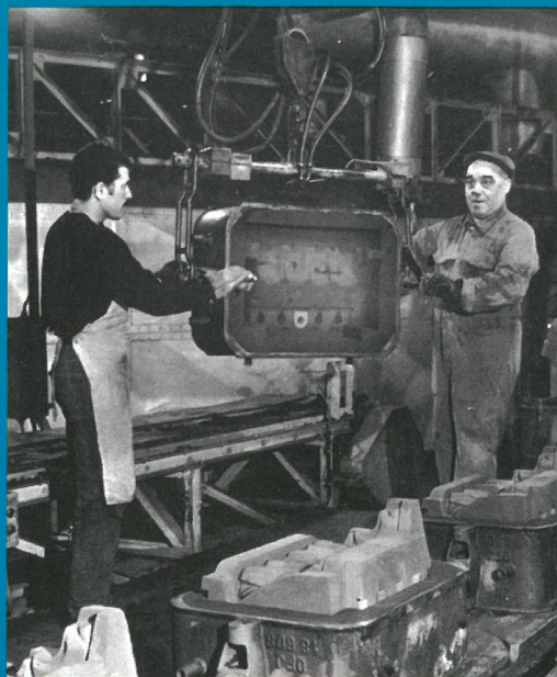
Puis on coiffe le moule de sa partie supérieure, dans laquelle des ouvertures ont été aménagées pour la coulée du métal et l'échappement des gaz.
