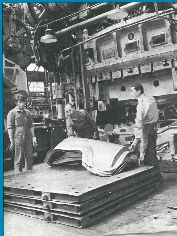
10. A la sortie de la presse, l'aile a trouvé sa forme : la presse débite environ 200 ailes à l'heure.
